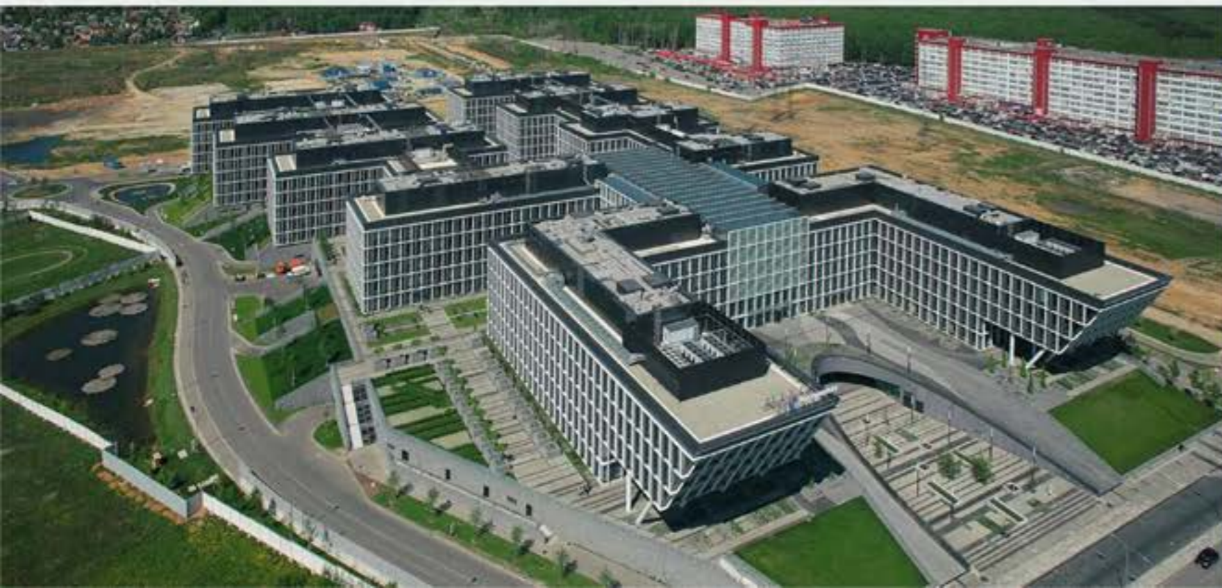
Бизнес центр Комсити в пос. Московский
