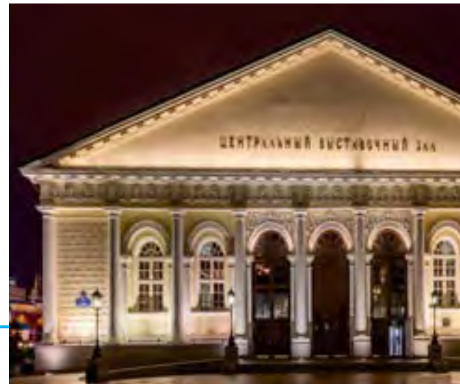
Реконструкция после пожара ЦВЗ «Манеж» 2005 год
